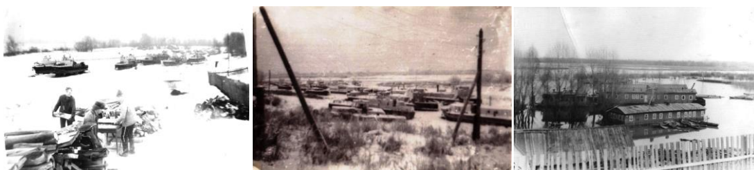
Зимняя стоянка катеров в затоне.
